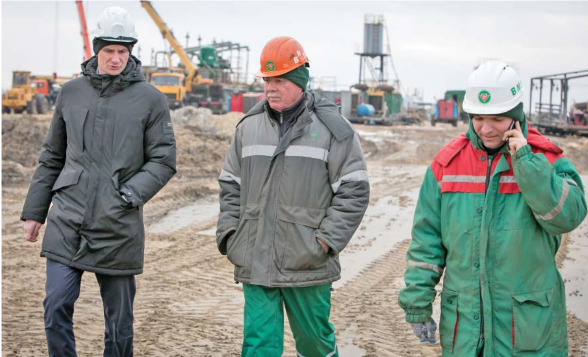
Скважина № 377 Речицкого месторождения. Слева направо: главный инженер ВМУ Николай СМОЛИКОВ, бригадир Виталий КАТИБА, прораб Сергей ЖУРАВЛЕВИЧ
