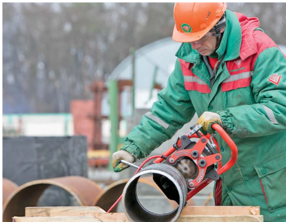
Монтажник технологического оборудования Виталий ЧЕРЛЕНОК работает с новым фаскорезом
